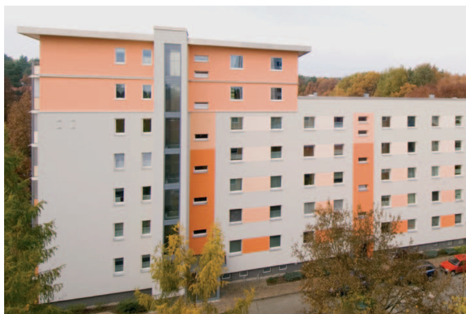
Zgodnie z krajowymi przepisami budowlanymi dla nadbudowy, odpowiednio do wysokości nowego budynku, wymagana jest okładzina trudno zapalna. Niepalna elewacja w systemie Bluclad spełnia w sposób pewny ten warunek. Zdjęcie: ideazione, Potsdam.
