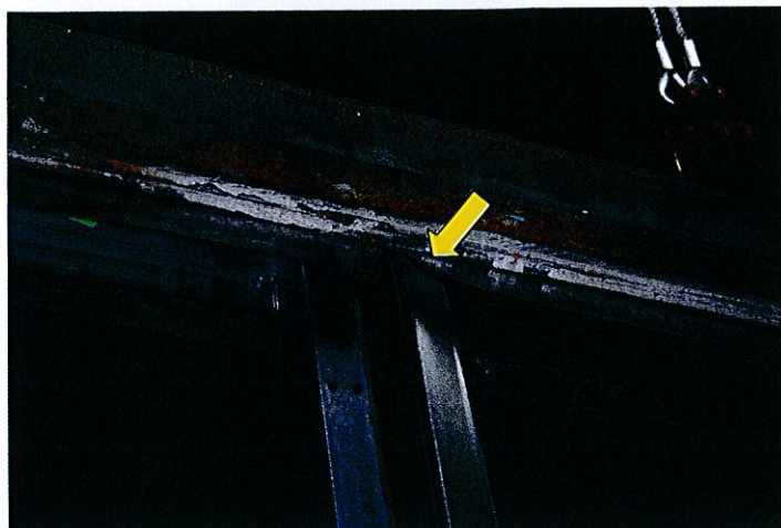
Fot 5. Uszkodzenia modelu 2
